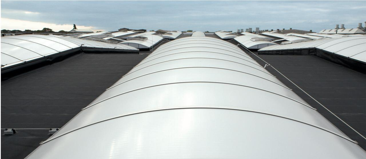
Mit seiner erweiterbaren Funktionalität ist das Lichtband *classic* ein millionenfach bewährtes System für das industrielle Flachdach. Ob zur reinen Belichtung, Belüftung oder für komplexe Rauch- und Wärmezuganlagen, das Lichtband *classic* bietet eine funktionale Lösung bei Standardanforderungen.
