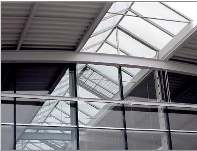
Fassadenlichtband SVCP mit Klappflügel,
