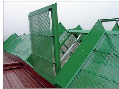
Fassadenlichtband SVCP mit Klappflügel,
