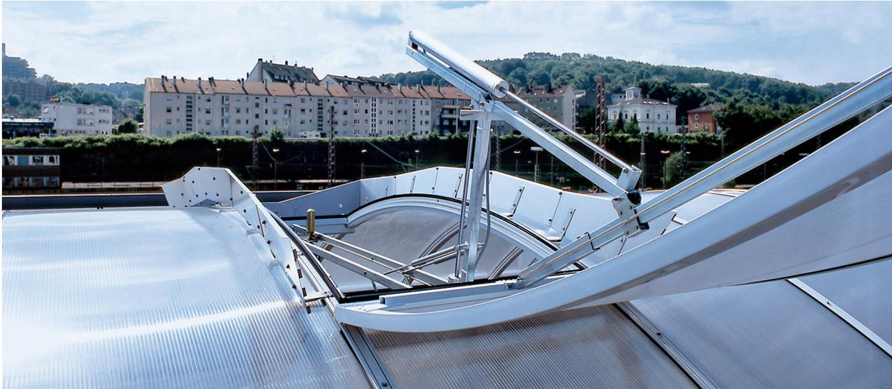
Das pneumatische NRW F6 ist im Lichtband *classic* für alle Klappensysteme nach DIN EN 12101-2 geprüft und zertifiziert. So hat das Gesamtsystem das Potenzial den bestmöglichen Personen- und Sachschutz im Brandfall zu gewährleisten.
